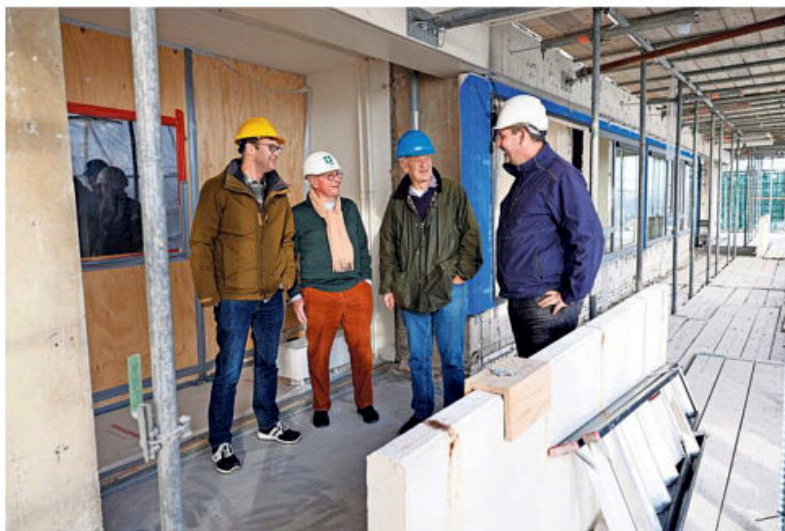
Jeroen Kwant, Dirk Kinebanian, Chris Haveman en John van de Weitgraven (vlnr) bij een appartement waar een tijdelijke houten muur is geplaatst.
