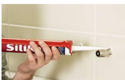
Nieuw kitwerk aanbrengen achter rozetten
